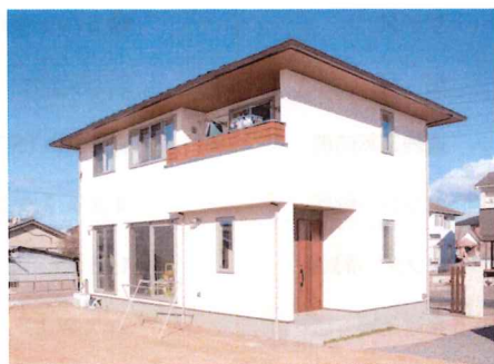
一般住宅の非常用電源として
