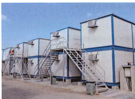
避難所や仮設住宅の非常用電源として
